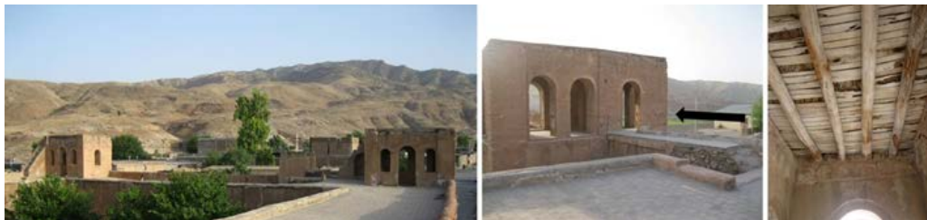
تصاویر ۴. راست: سقف تیرپوش اتاقک‌ها - وسط: اتاق سردر بنا میرغلام و مسیر دسترسی به آن - چپ: اتاقک‌های ضلع جنوبی (نگارنده).
