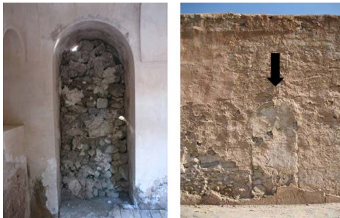
تصاویر ۷. ورودی مسدودشده در ضلع غربی بنای میرغلام هاشمی از نمای بیرون و درونی آن (نگارنده).
